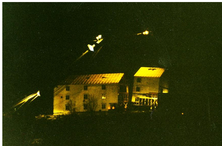
Den første og største delen er komen på plass, og fremste og minste på 8 meter heng i krana.
