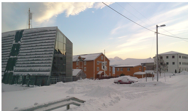
Anlegget til Ishavsmuseet i Brandal.
