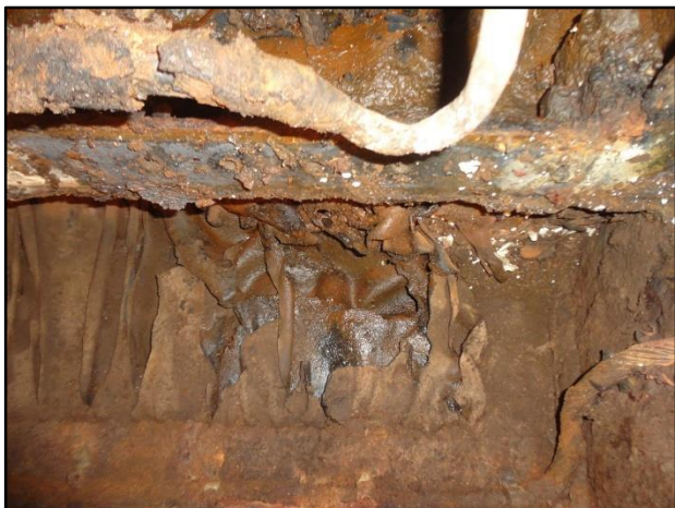
Innsida av boks for ekkolodd før reparasjon.
