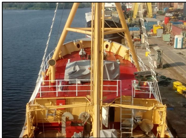
Nymåla og ferdig bakkdekk.
