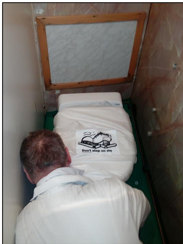
Det første av dei fire Jets-toaletta vert montert.
