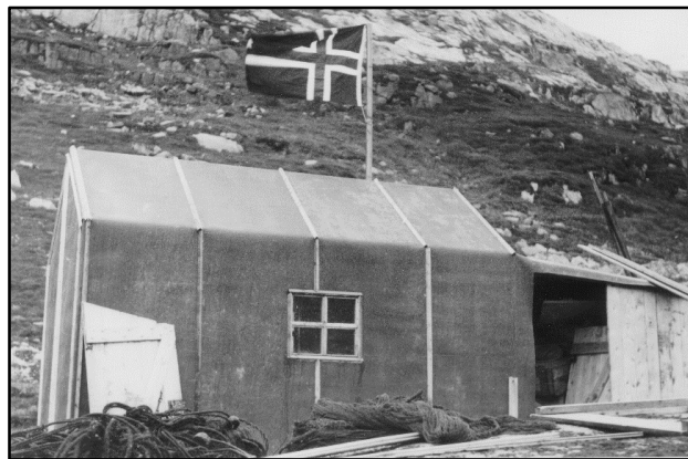
Den ferdige Hovedstasjon. Foto Tornøe
