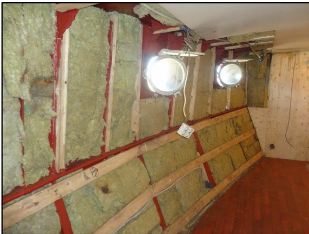
Nytt stål og ny isolasjon i messa.
