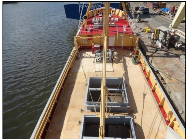
Nytt plankedekk skal også på plass.
