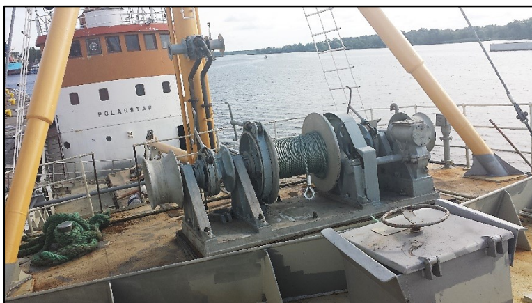
Nyrenovert ankervinsj koma på plass igjen.
