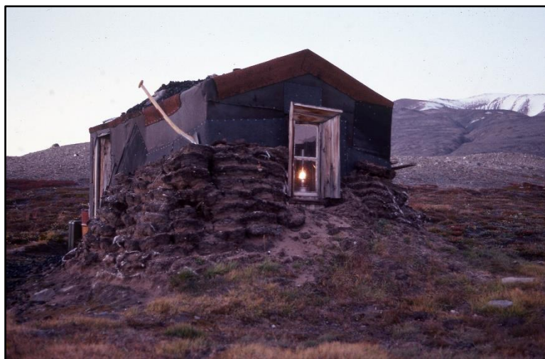
Utvendig er bare vegger og tak dekket med tjærepapp
