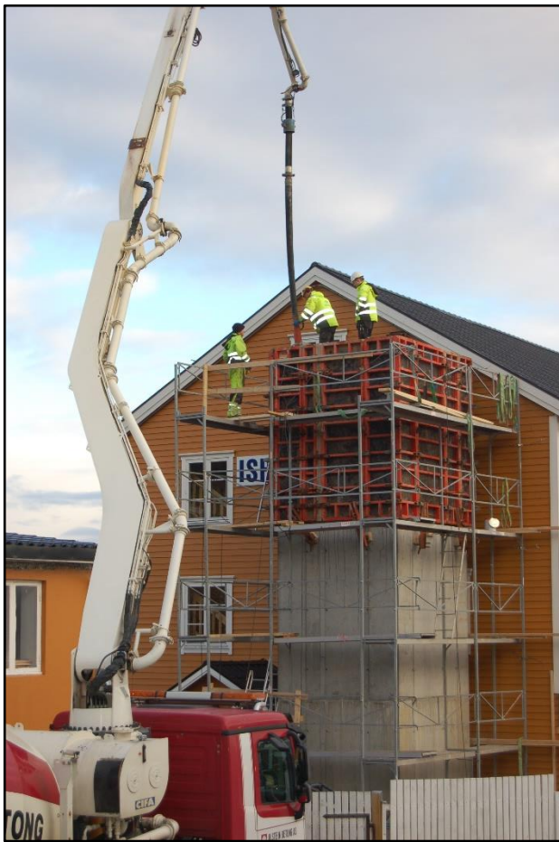
Støyping av siste høgda på sjølv heissjakt.
