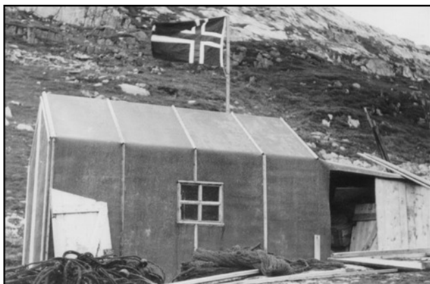
Den ferdige Hovedstasjon. Foto Tornøe
