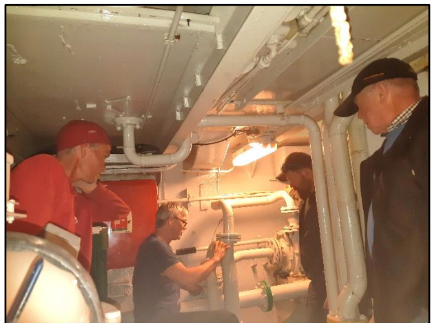
Skruing av rør og sjøkjølevasspumpe, frå venstre Knut Eivind Nasset, Jon Bøe, Andre Overvåg og Terje Valderhaug
