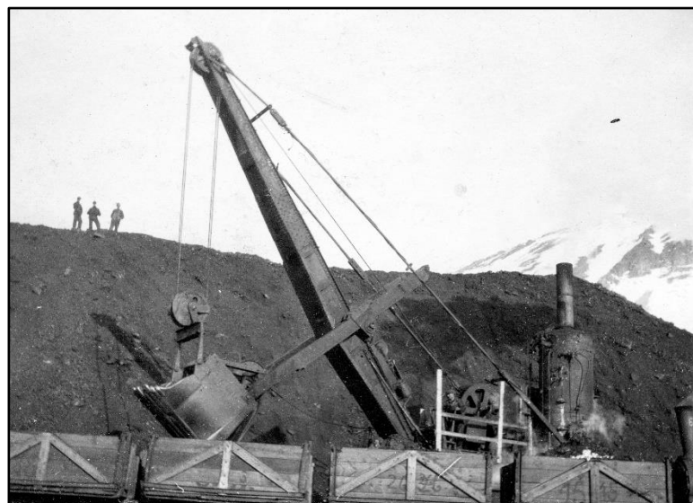
Den store lastemaskin ved kolhaugen. Foto Hans Hjelle
